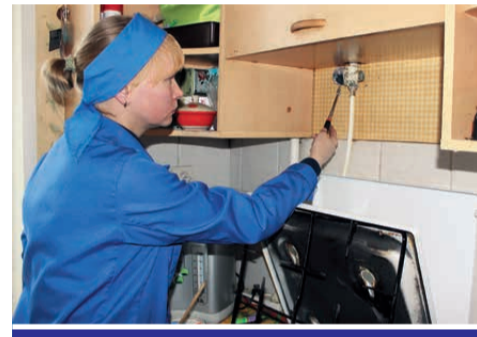
Екатерина при помощи мыльного раствора и зеркала ищет утечку
