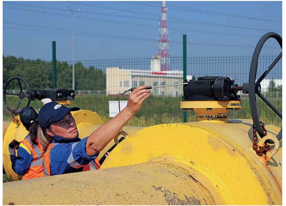
Ольга проверяет газоанализатором трубопровод к ГРПБ
